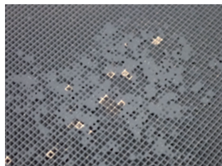
DPRに煤が堆積した事例
