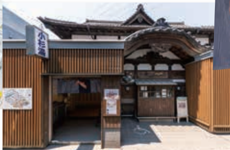
神社仏閣を思わせる宮造りの木造建築。中央のカーブを描いた唐破風屋根は、関東大震災の復興シンボルとして当時の銭湯建築で流行した。
