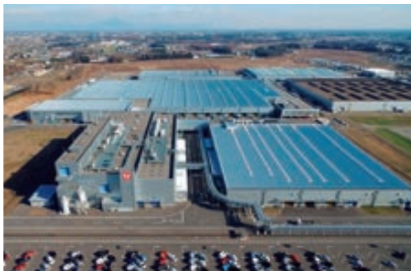
古河工場全景
