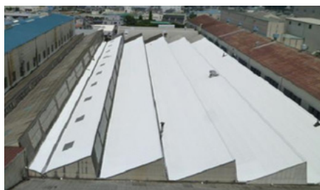
屋根への遮熱塗装
