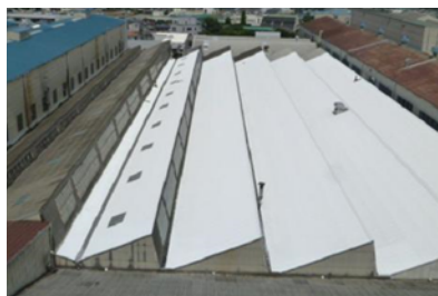
屋根への遮熱塗装
