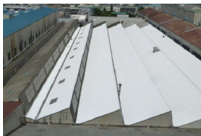
屋根への遮熱塗装
