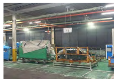
建屋内壁に設置した防音シート
