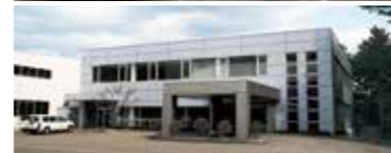
プレート加工をしている本社工場の建屋(上)と、営業部門と管理部門のある本社社屋(下)の外観。
