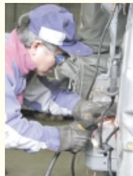
塗装作業にも制限
