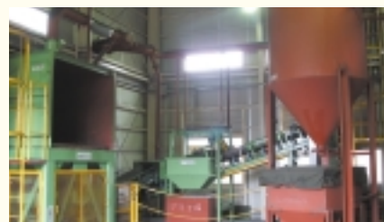
鋳砂再生工場
