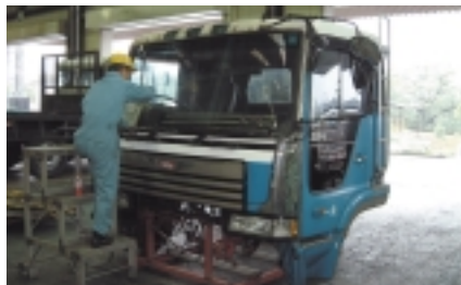
解体作業風景
