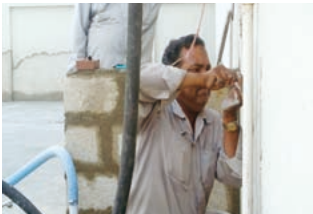
電気配線工事(日野バック従業員)
