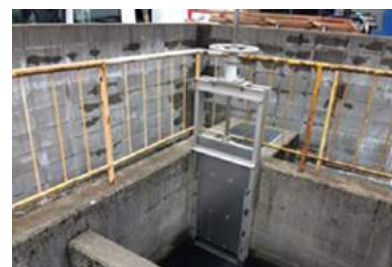
異常排水流出防止用遮断堰
