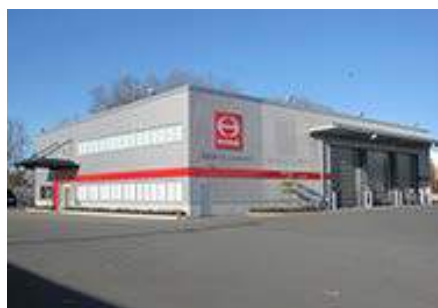
お客様テクニカルセンター外観
