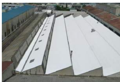
屋根への遮熱塗装
