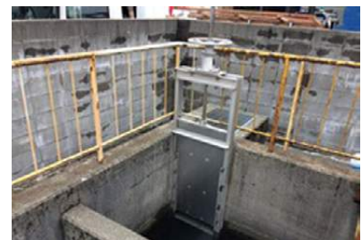
異常排水流出防止用遮断堰
